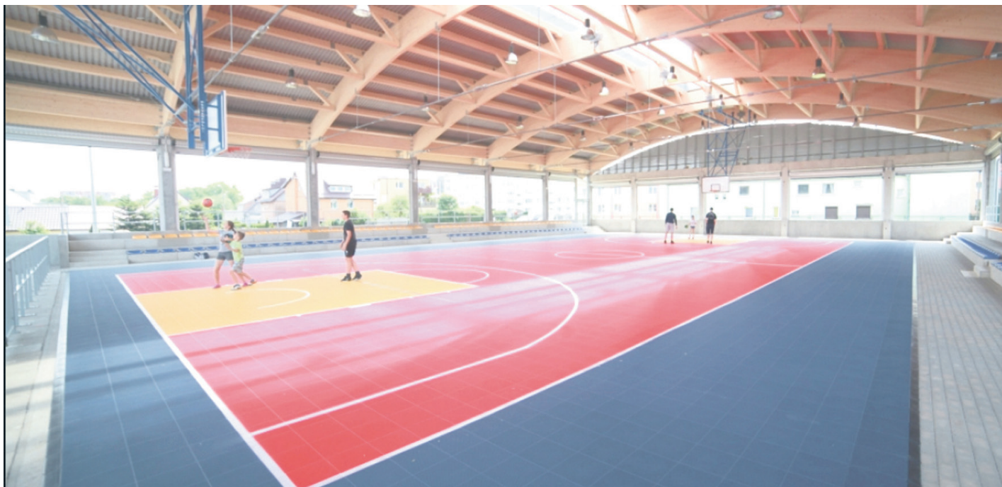
Ściany boczne mają postać opuszczanych żaluzji. Sprytna hala kosztowała tylko 2 miliony złotych.
