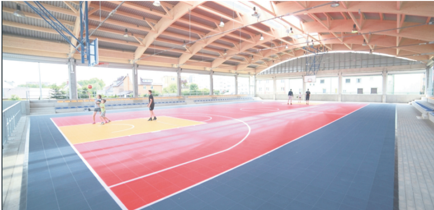
Ściany boczne mają postać opuszczanych żaluzji. Sprytna hala kosztowała tylko 2 miliony złotych.
