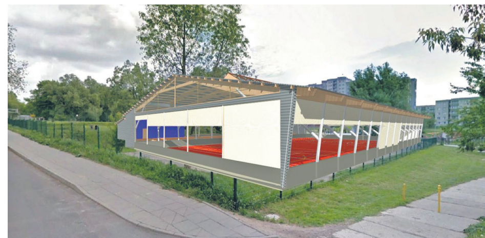
Stare boisko asfaltowe dzięki zadaszeniu i nowej nawierzchni dostanie drugie życie.
